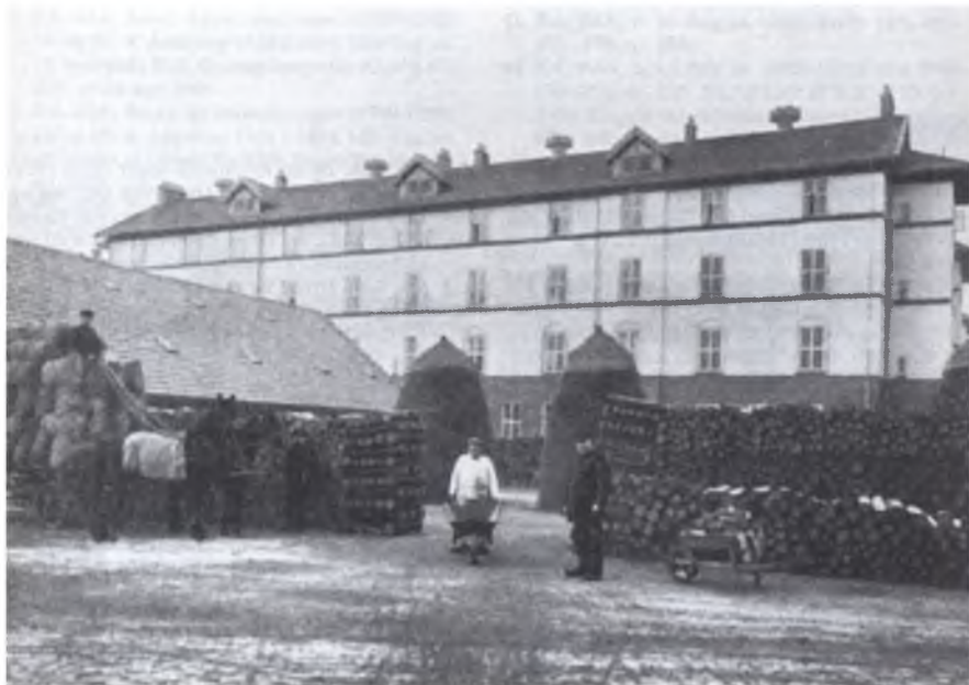
Fig. 19: Sundholm, ca. 1928. I 20 års jubilæumsskiftet fra 1928 står der: »Beliggende bag et Plankeværk ser man nogle store Brændepladser, hvor ca. 75 Mand daglig beskæftiges under Tilsyn af en Opsynsmand. Brændet leveres herfra til offentlige Institutioner, til Aldersrentenydere og til en del Private.« Billede og citat bringes med tilladelse fra Sundby Lokalhitoriske Forening.
